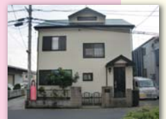
田中邸外部改修
